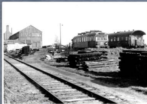
▲ Bahnhofsbereich Willinghusen/ Stemwarde (Quelle: FV Südstormarnsche Kreisbahn e.V./ Schomann)
